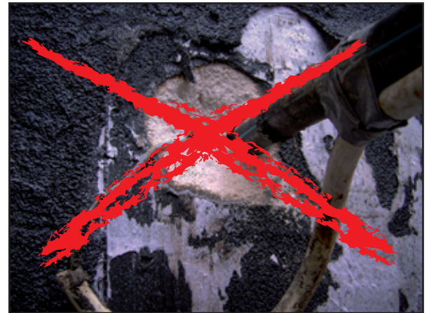
Nicht fachgerechte Einbindung der Gebäudeabdichtung
